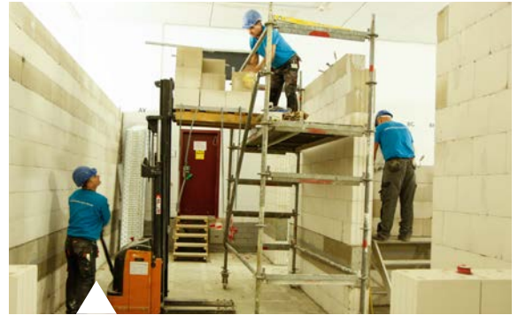
Hier entsteht ein zusätzliches Versorgungszentrum für Strom und Klimatechnik.
