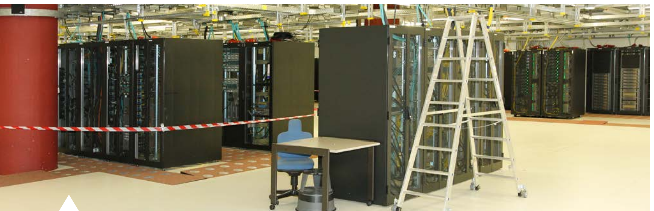
Die Serverschränke werden umgebaut und künftig direkt durch den Doppelboden mit kalter Luft versorgt. Das ist wesentlich effizienter, als den ganzen Raum zu klimatisieren.
