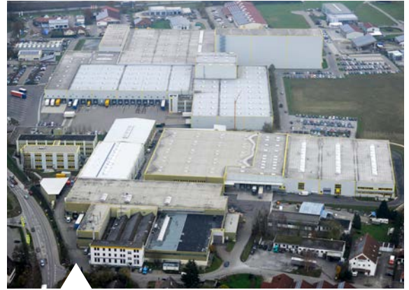
Logistikzentrum in Obersontheim
